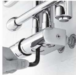
Dokręcamy zawór do grzejnika
